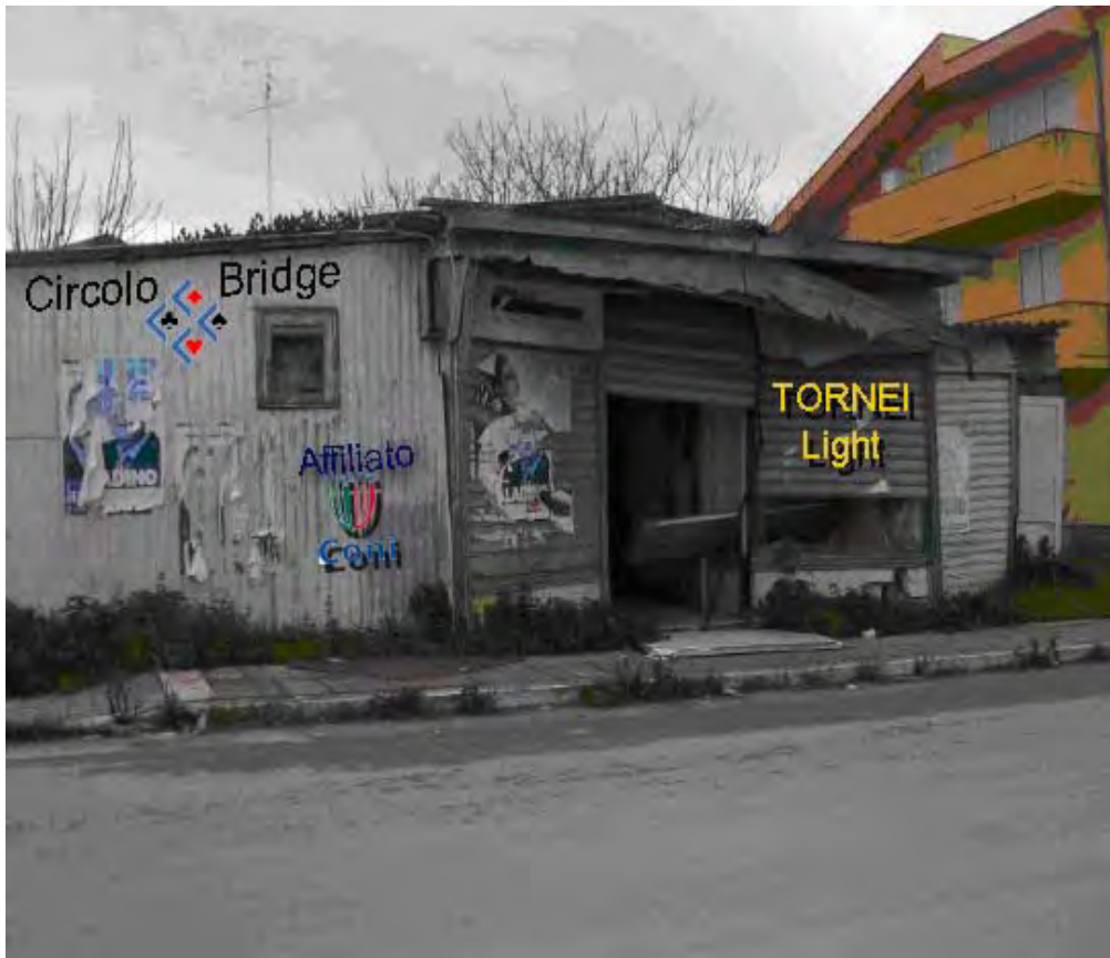
Un noto circolo di bridge in Italia
